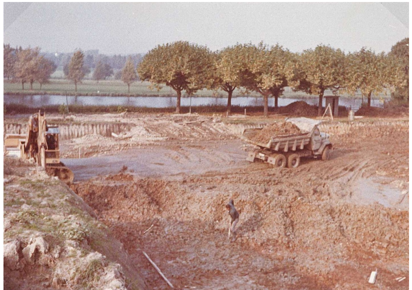
Der Untergrund wird vorbereitet
